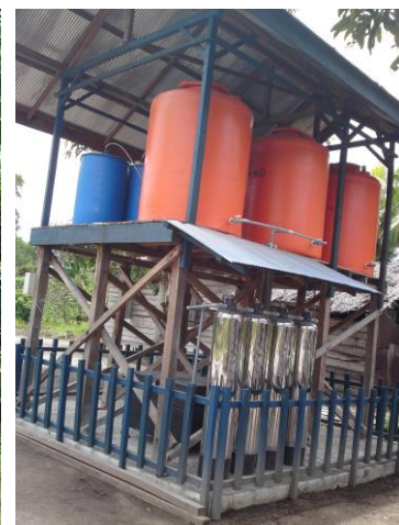
Gambar 14 & 15. Bantuan penampungan dan penyulingan air di Desa Sebangau Permai. Sayangnya penyulingan air sudah tidak berfungsi lagi
