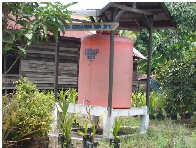
Gambar 14 & 15. Bantuan penampungan dan penyulingan air di Desa Sebangau Permai. Sayangnya penyulingan air sudah tidak berfungsi lagi
